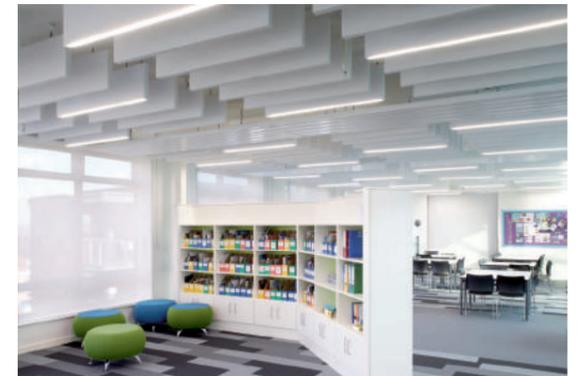
**BTK B: harmonische Deckenstruktur und Ausleuchtung durch die Kombination von Akustik- und Lichtbaffeln**
